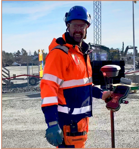
Skanskas arbeid på Fornebubanen
