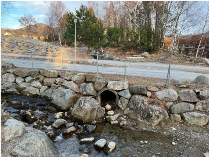
Bilde: Kommunal stikkrenne (Foto: Geir Magnus Tunglund, Statens vegvesen)
