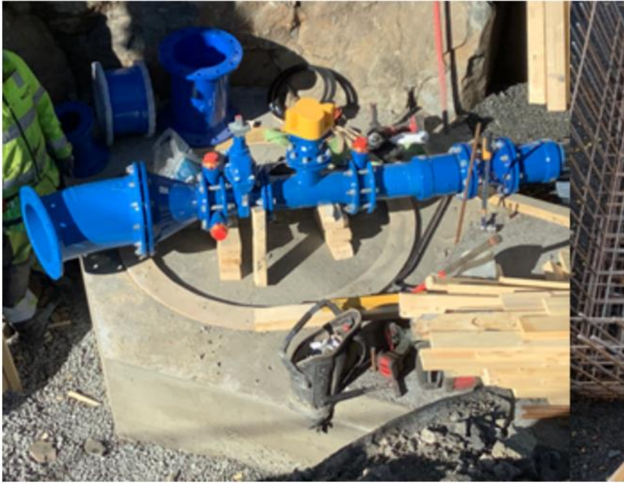
Kumbilder før støp av bunnseksjon.
